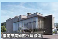
備前市美術館（建設中）
