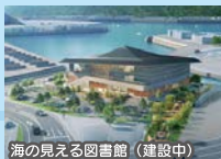
海の見える図書館（建設中）
